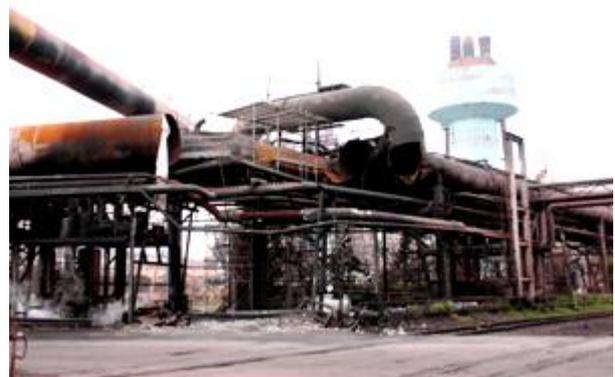
損傷部を入れ替えて新設復旧工事中
