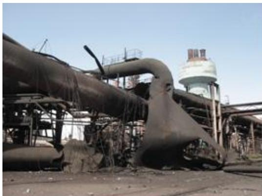
地震により落下し破損したコークスガス配管
