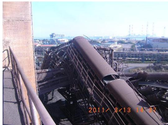
折れ曲がって破損した高炉付帯設備
