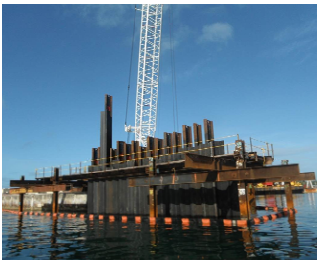
ハット形鋼矢板 + H形鋼の施工概況
