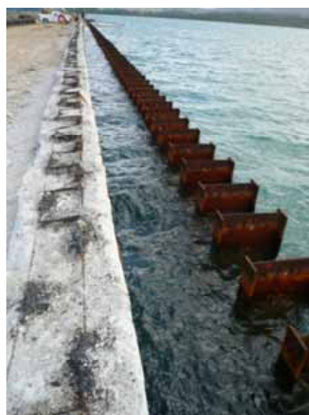
ハット形鋼矢板 + H形鋼の施工後の概況
