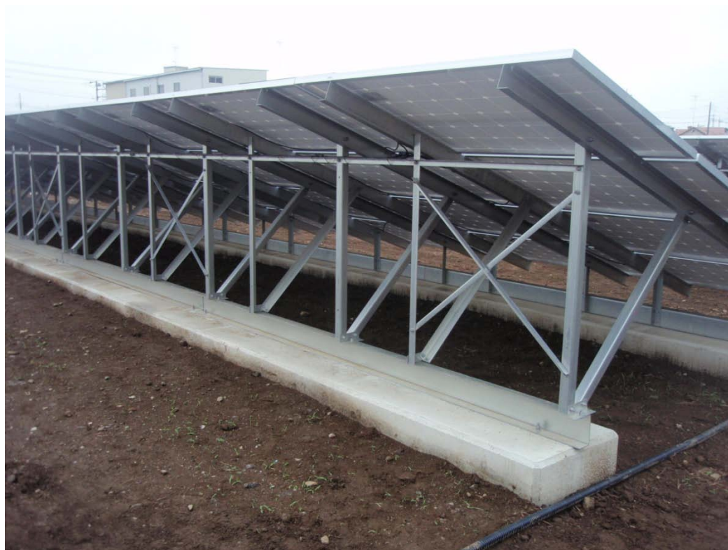
【写真】 太陽光発電架台使用例 「館林ソーラーパーク」(JAG国際航業グループ提供)
