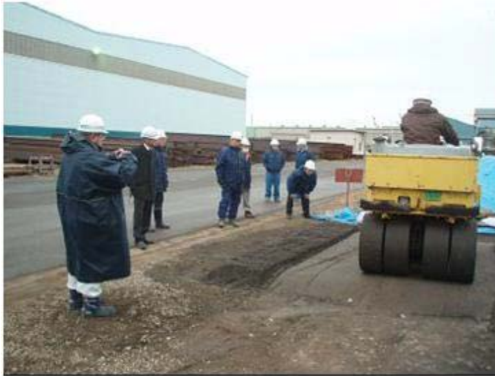
< 図－1 締固め試験状況 >
