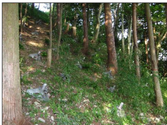
ノンフレーム工法施工事例1
