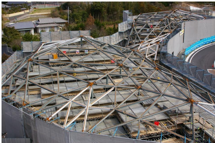
【大スパン鉄骨事例（下関市川棚交流センター）】
