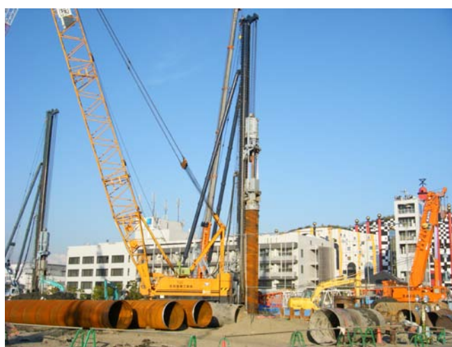
(図2) プロロジスパーク舞洲IVプロジェクト(施工状況)
