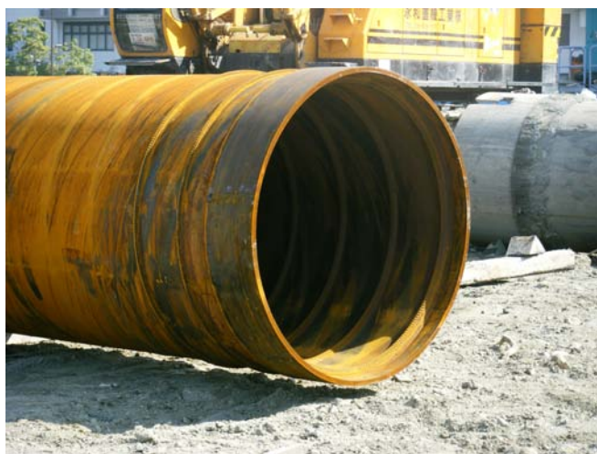
(図1) 杭径φ1,400の鋼管杭(国内初採用)
