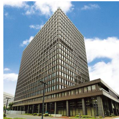
コルテンを使用した新日鉄旧本社ビル
