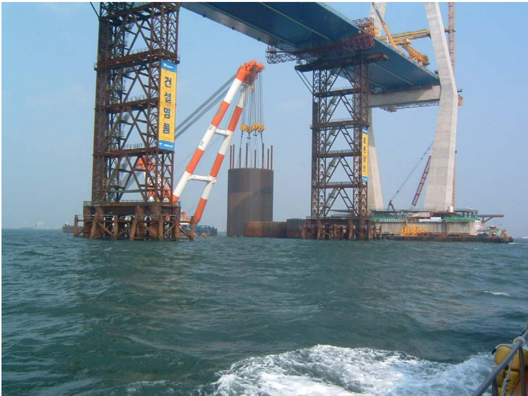
図4 施工中写真 (写真撮影 新日鉄)
