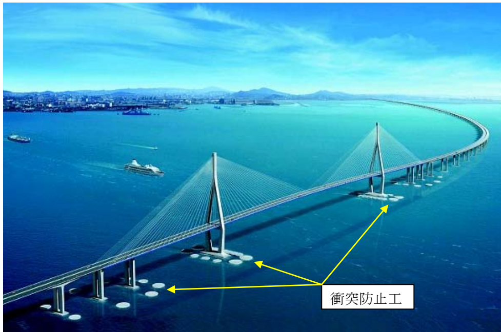
図面1 衝突防止工使用イメージ（写真提供：サムスン建設）
