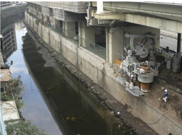
○古川護岸整備工事（空頭制限箇所での施工例）
