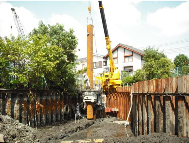
○内川護岸改修工事
