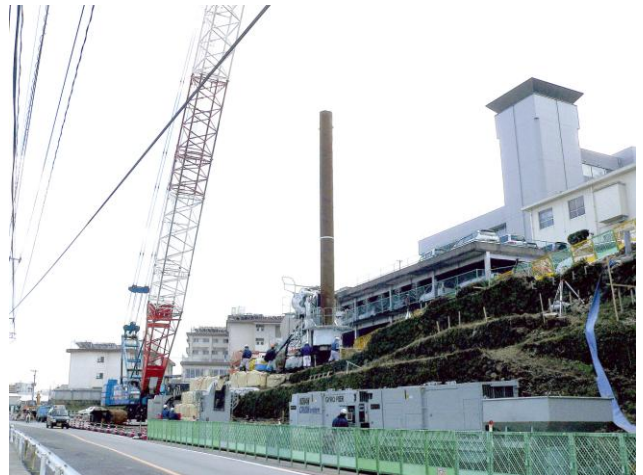
○加世田道路擁壁建設工事（道路擁壁への適用例）
