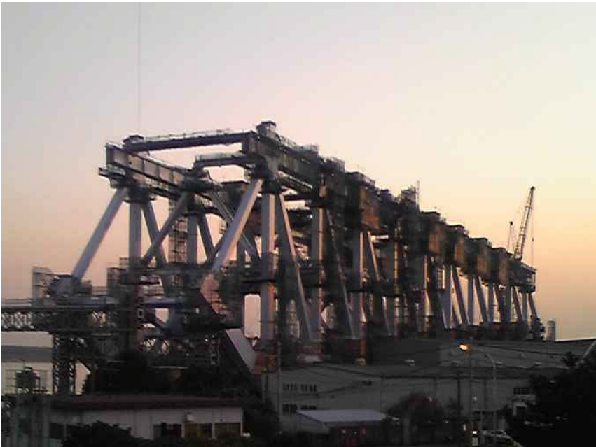
図一2 地組製作状況（東京都江東区有明 3-17 臨海大橋その1 川田工業作業所）
