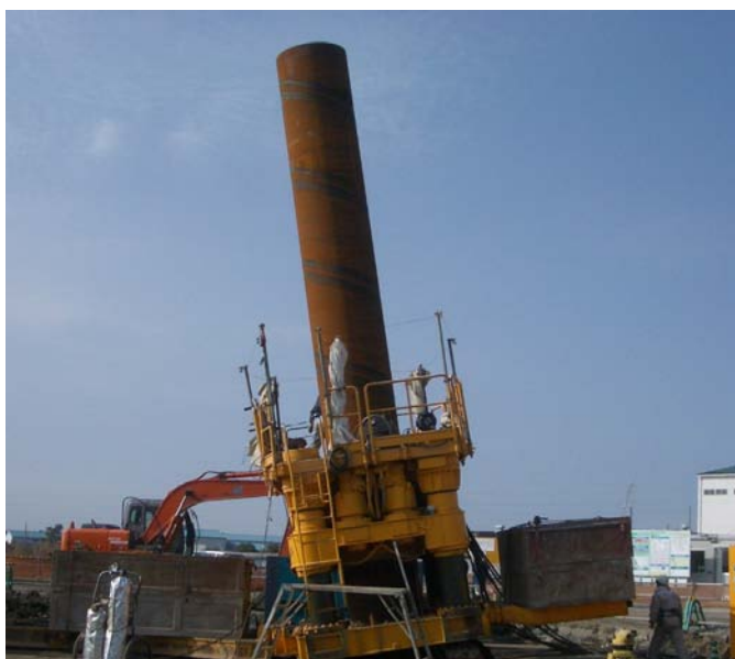
NSエコパイル斜杭施工状況
