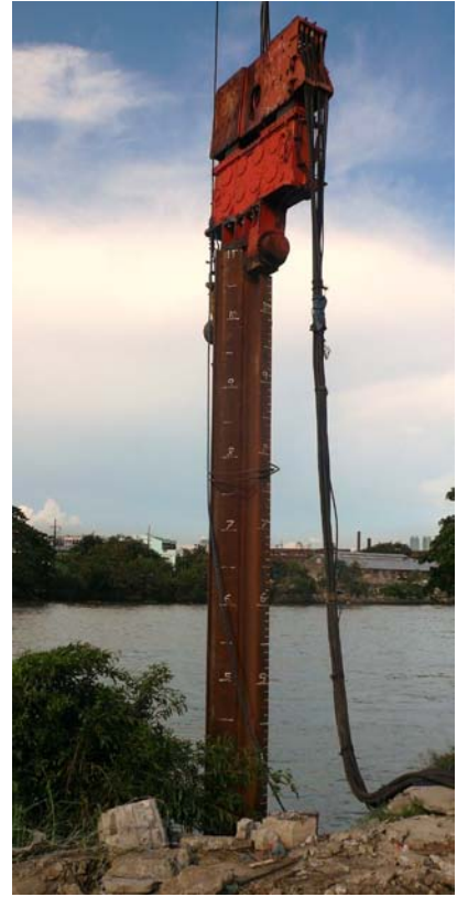
<施工試験状況写真>
