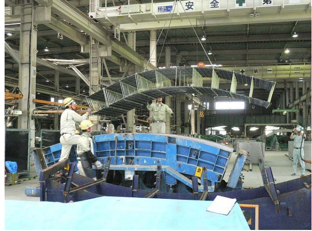
外径φ12m級の大口徑セグメント製作状況
