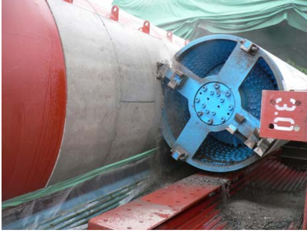
先行トンネル切削実証試験 概況
