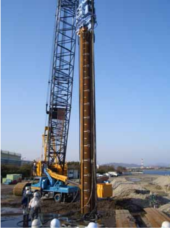
図-3 杭施工状況
