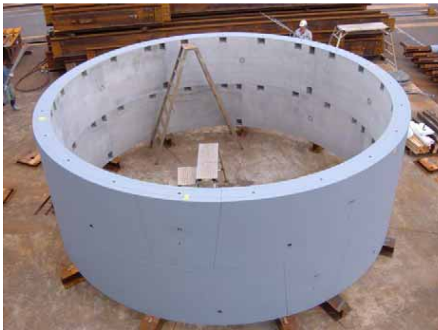
写真.3 工場にて2リングを水平仮組した状況
