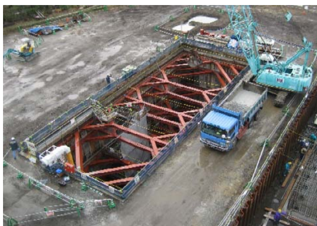
掘削状況写真
