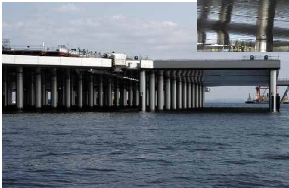
(写真3) チタンカバープレートが採用された新滑走路棧橋部
