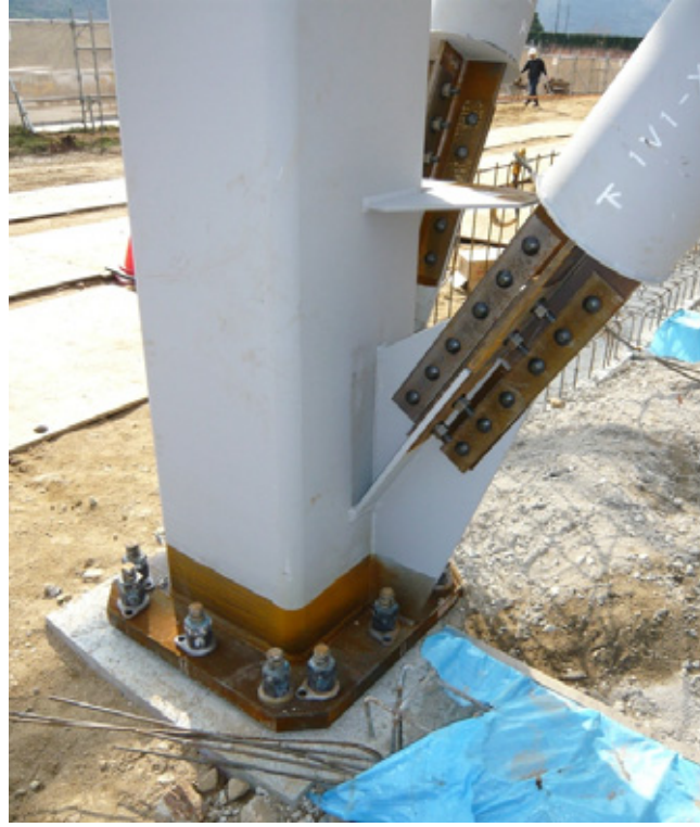
写真 1 : 1 階柱脚部写真
