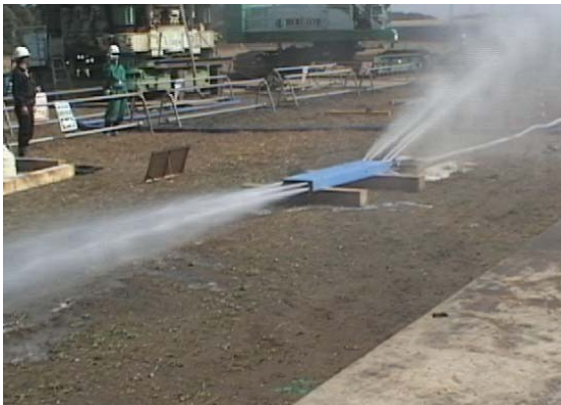
写真-3 ウォータージェット噴出状況 (継手洗浄前の試験噴出状況確認)
