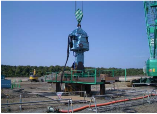
写真-1 試験杭打設状況
