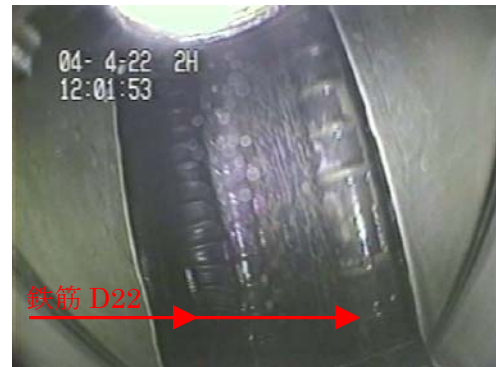
写真-4 継手部洗浄状況 (ボアホールカメラで撮影)
