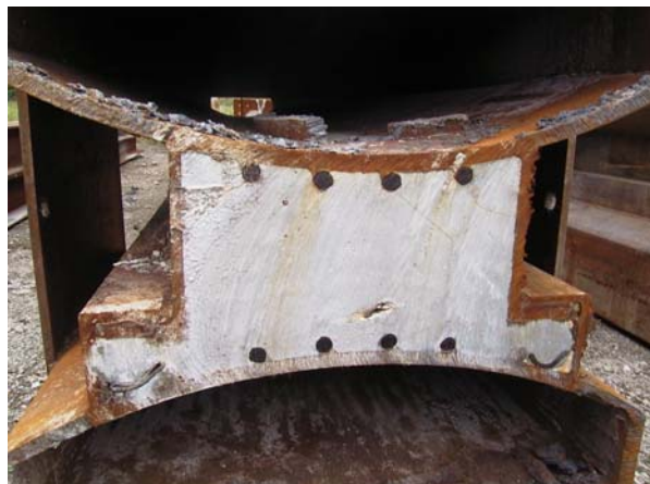
写真-5 モルタル充填状況確認
