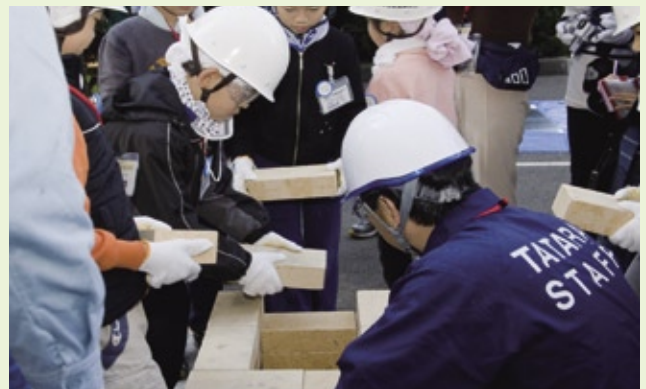
2班に分かれて耐火レンガを積み上げ「たたら炉」を築く
