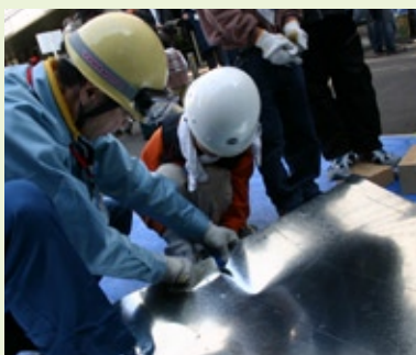
薄鋼板を切り抜き炉に乗せる煙突を作る
