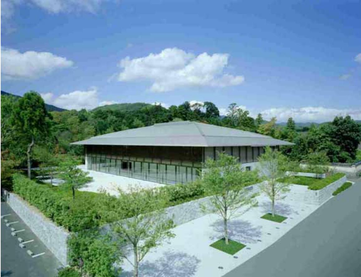
\* 屋根の上部が日本瓦、下部が日本瓦の風合いをもつアルミナブラスト仕上げのチタン材。
