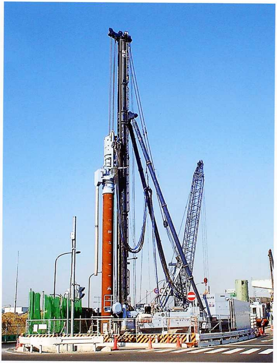
適用例：ガンテツパイル（鋼管ソイルセメント杭工法）
