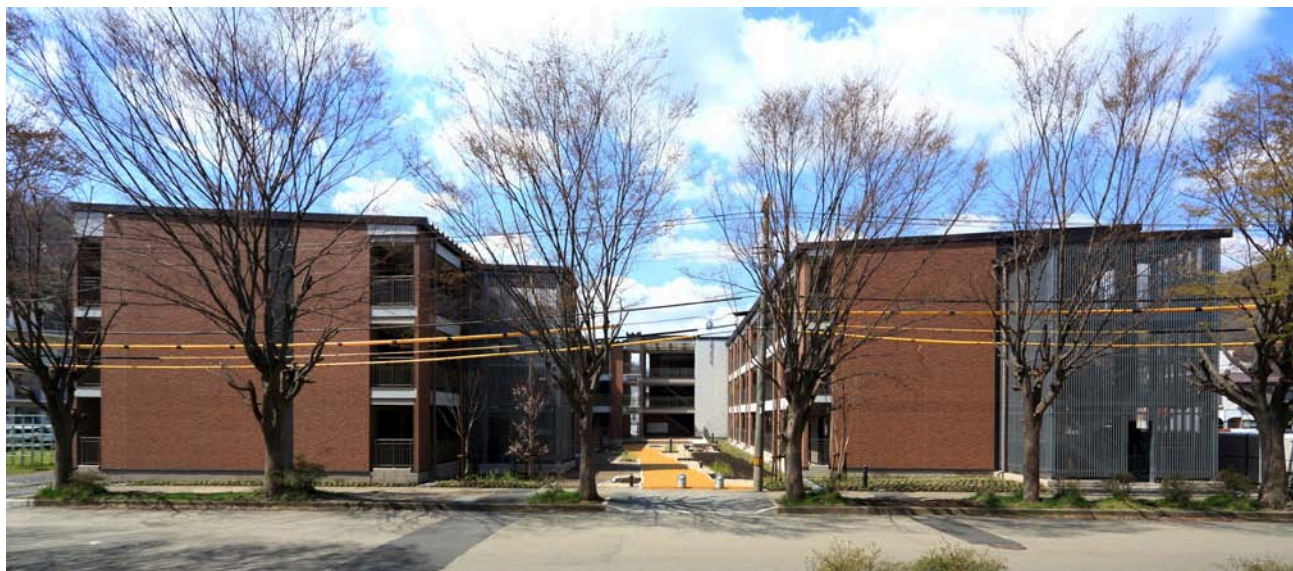
〔参考〕第Ⅰ期(1号棟)竣工写真
