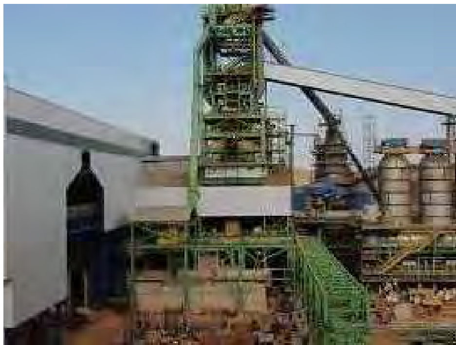
完成真近の高炉
