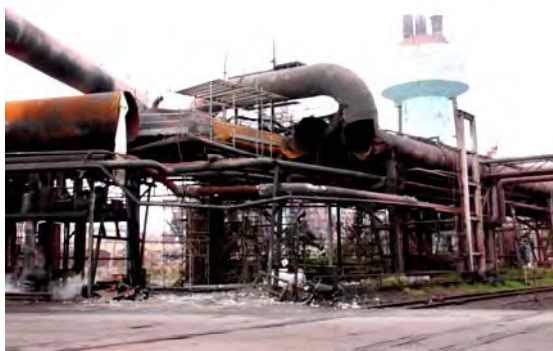
損傷したガス配管(↑)と 復旧後(↓)
