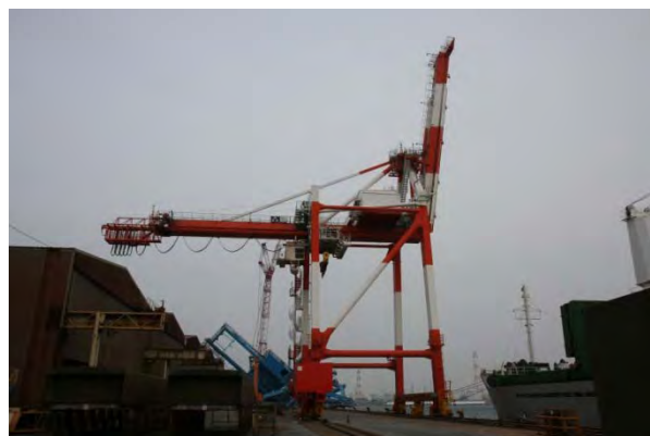
和歌山から移送した出荷クレーン
