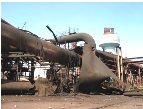
損傷したガス配管(↑)と 復旧後(↓)
