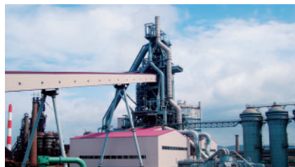
和歌山製鉄所 新第1高炉
