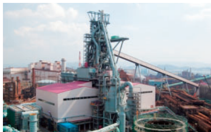
建設中の和歌山製鉄所 新1高炉
