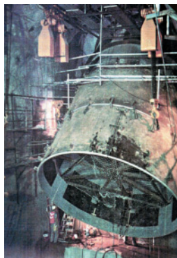
建設中の水圧鉄管
