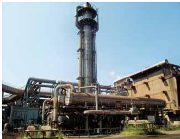
世界初のカーリーナサイクル発電設備（鹿島製鉄所）
