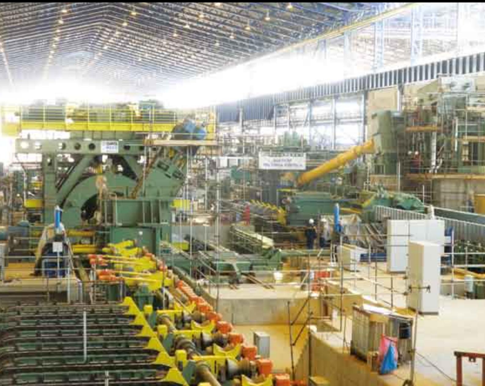
ブラジルで建設中の高炉一貫シームレスパイプ製造工場
