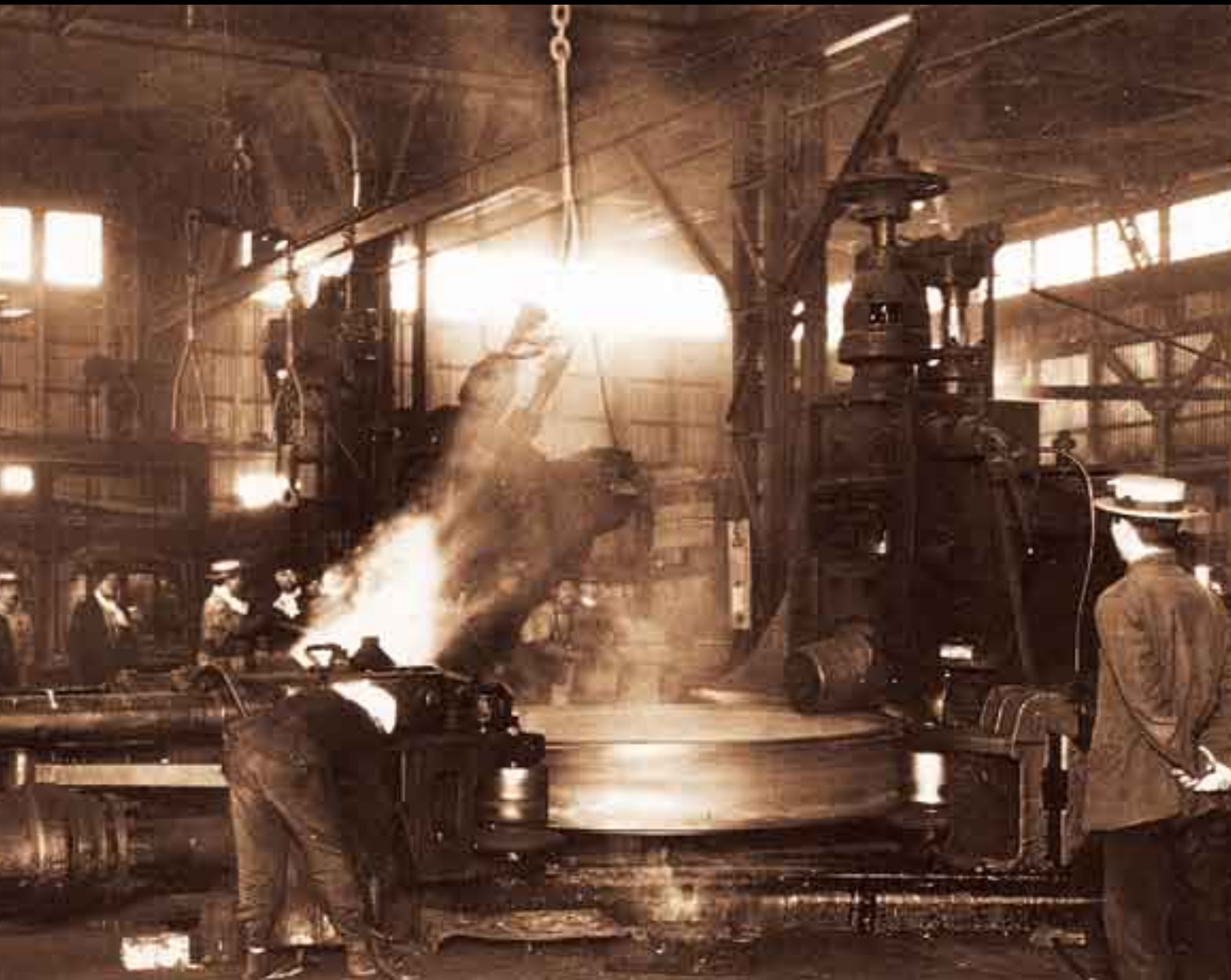
住友鋳鋼場の鉄道車輪（外輪）の圧延機
