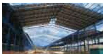
現在建設中のブラジル高炉一貫製鉄所
