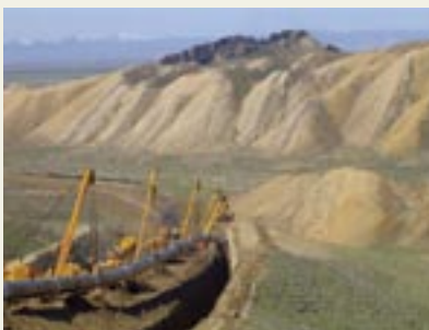
パイプライン
