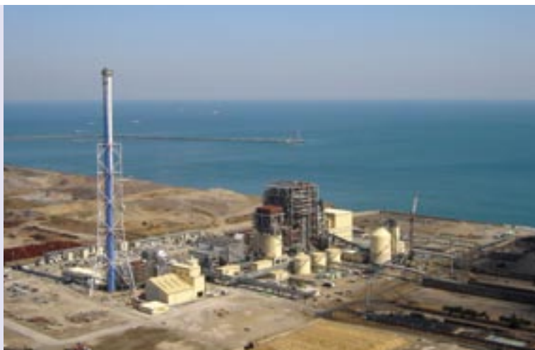
建設中の電力卸供給 (IPP) 用発電設備
