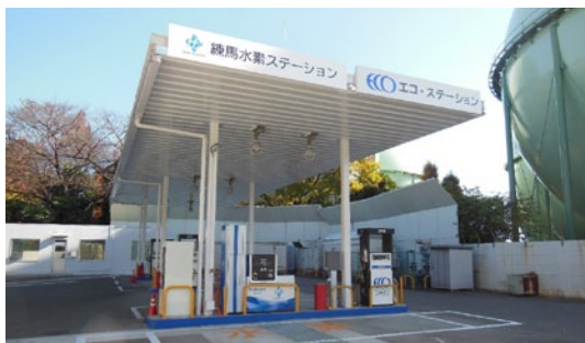
水素ステーション
