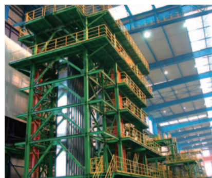
WINSteel 社電気錫めっき設備
