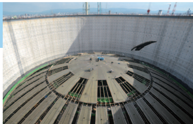
LNGタンクに使用される7%ニッケル鋼板 ©大阪ガス(株)
