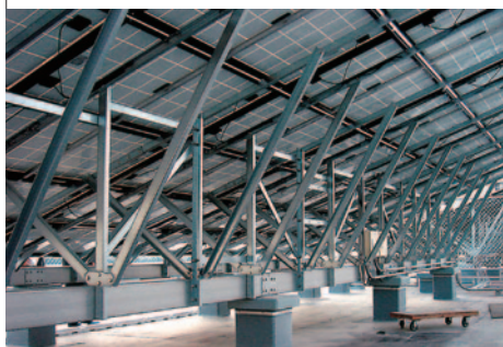
スーパーダイマ ® ソーラーパネル設置用架台使用例
