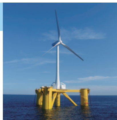
2MWダウンwind型浮体式洋上発電設備「ふくしま未来」(風車直径約80m) ©福島洋上風力コンソーシアム
