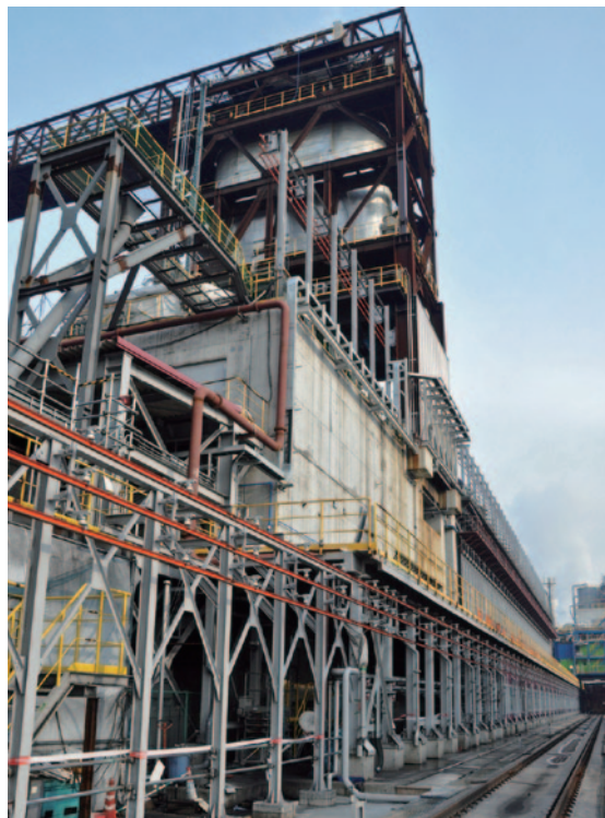
名古屋製鐵所の次世代型コークス炉 (SCOPE21)
