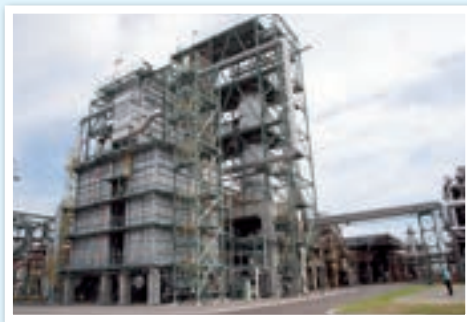
大分製造所No.2スチレンモノマー製造設備
