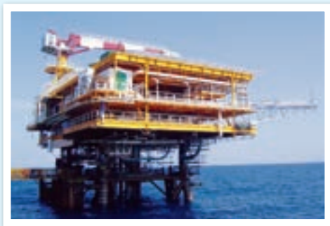
タイ沖合の石油天然ガス採掘プラットフォーム
