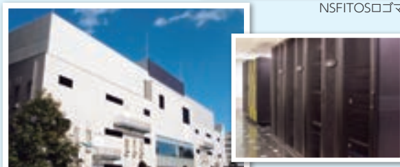
次世代型データセンターである第5データセンター
