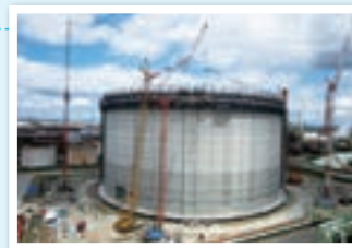
7%ニッケル鋼板が採用された建設中の大阪ガス(株)東北第一工場5号タンク 内容量23万m 3 の世界最大級のLNGタンクで、同製品約3,800トンが使用される
