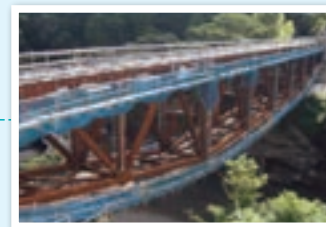
施工中の新宮川橋
