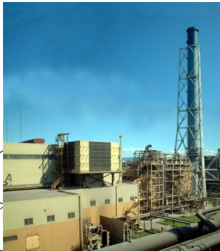
(フル稼働中の君津共同火力(株)) 5号機全景
