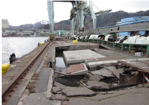
(被災した製品岸壁)
