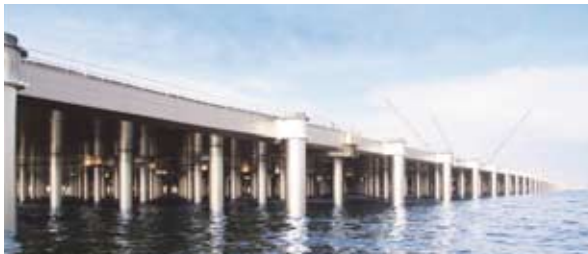
東京国際空港（羽田空港）の再拡張事業におけるD滑走路
