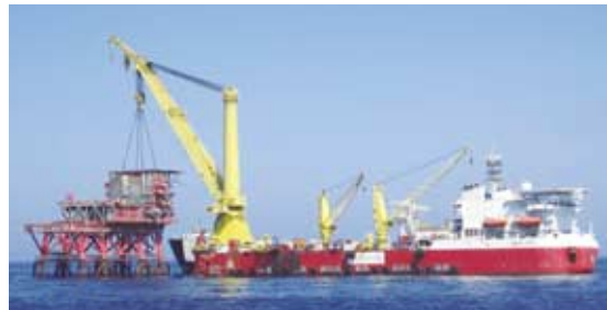
撤去中の天然ガスプラットフォーム
