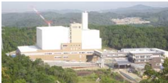
施工中の愛知県岡崎市溶融炉
