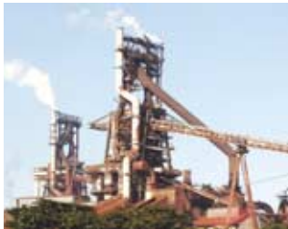
君津製鐵所第2高炉
