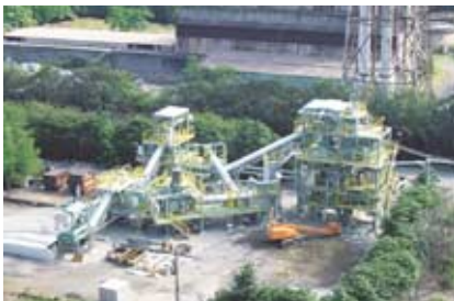
使用済み耐火物の破碎・粉碎プロセス(大分製鐵所)
