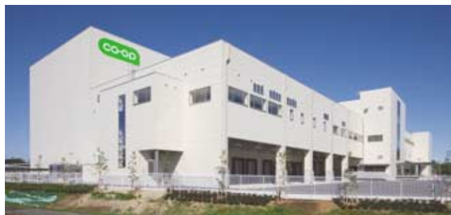
コープネット印西要冷センター
