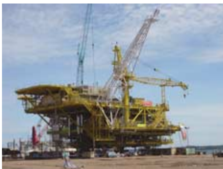
インドネシアで製作中のガス生産用プラットフォーム
