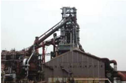
改修を終えた名古屋製鐵所第1高炉
