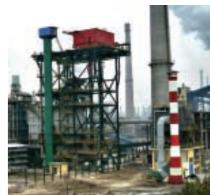
武漢鋼鉄 集団 公司コークス工場No.2CDQ設備
