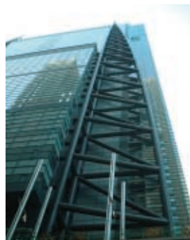
外部露出仕様・円形鋼管使用 2003年 日本テレビタワー(東京)
