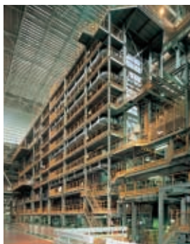
溶融亜鉛メッキ鋼板製造設備
