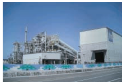
北九州エコエナジー(株)「複合中核施設」
