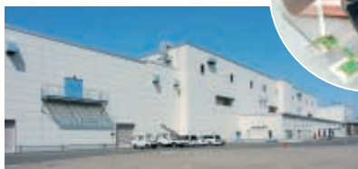
同社九州製造所(福岡県北九州市)新工場
