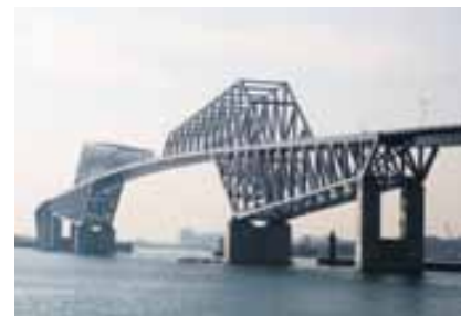
東京ゲートブリッジ全景
