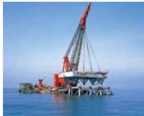
海洋エネルギー資源開発施設の施工
