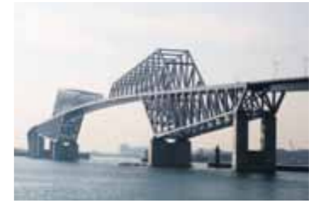
東京ゲートブリッジ全景
