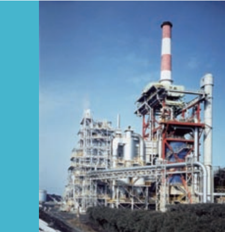
コークス乾式消火設備（CDQ）
