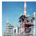
コークス乾式消火設備（CDQ）
