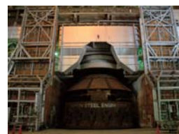
新設した名古屋製鉄所6号転炉
