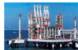
液化天然ガス受入設備
