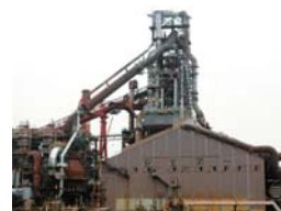
拡大改修した名古屋製鉄所第1高炉
