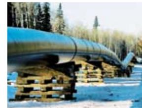
高強度鋼管を使用したパイプライン
