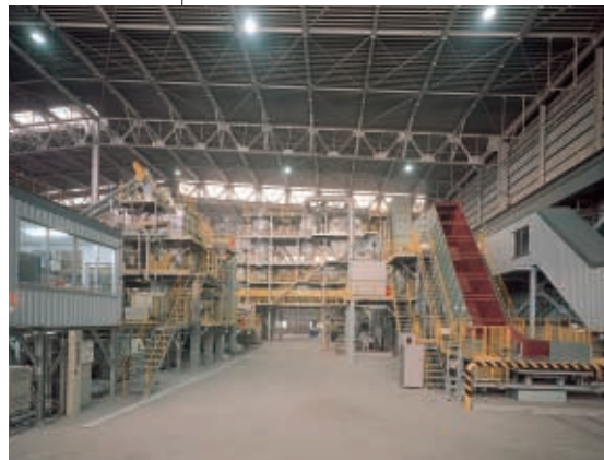
八幡製鉄所 家庭用プラスチックリサイクル設備
