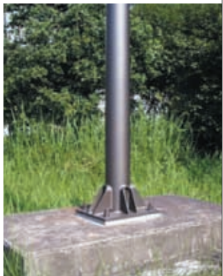
基部にU字リブ構造を適用した鋼管ポール
